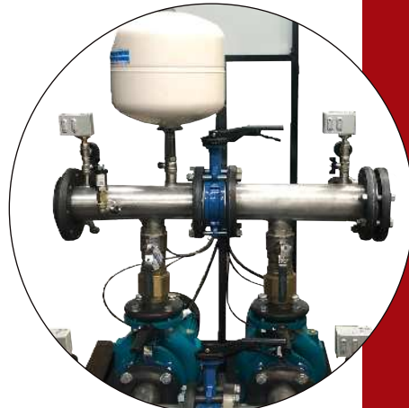
Насосная станция для перерабатывающего завода
